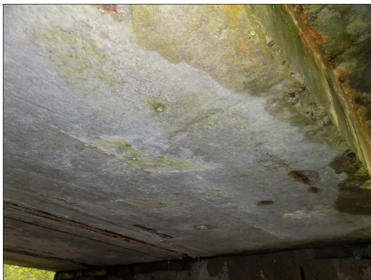
Krajní nosník, zatékání pod pravou římsou
