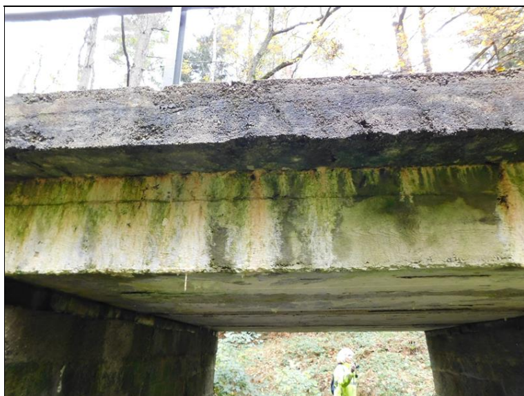
Zatékání pod levou římsou
