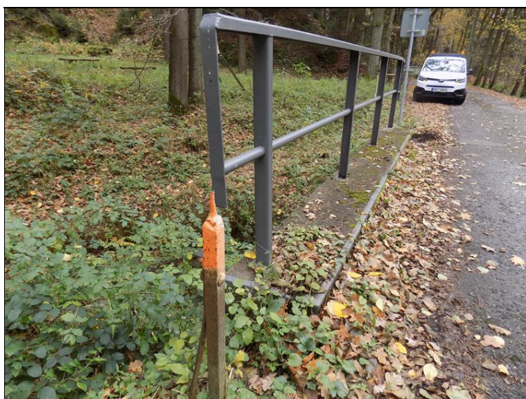
Pravá římsa, zbytek původního zábradlí
