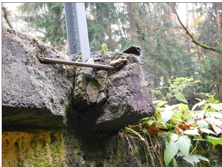
Poškozená levá římsa nad křídlem opěry OP1
